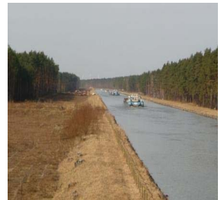
Blick auf die HOW; auf der linken Seite erfolgt die Verbreiterung
