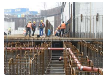
15.03.2011 – Arbeiter beim Einbau einer starken Bewehrung aus Stahl für Stahlbetonwanne
